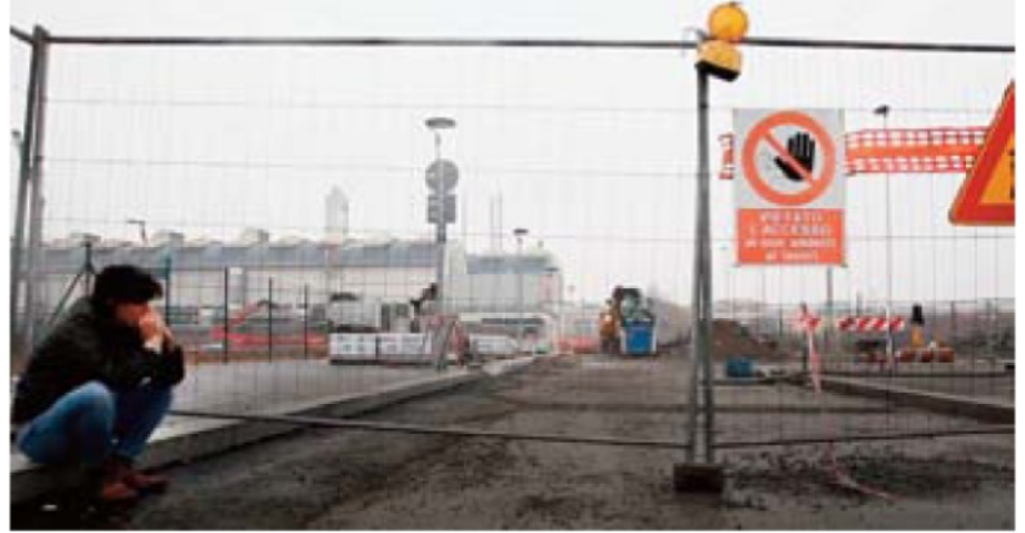
Immagine di lavori in corso
